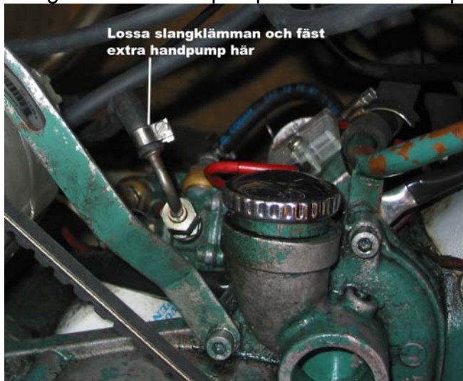
Bild 2.3, Visar var man kan ansluta en extra handpump för att suga fram bränsle från tanken.
