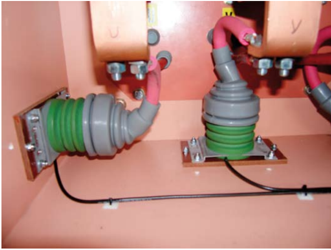
KUVA 6 Suurjännitemoottorin kiinteä PD-anturointi moottorin kytkentäkotelossa (Fortum kuva-arkisto).
