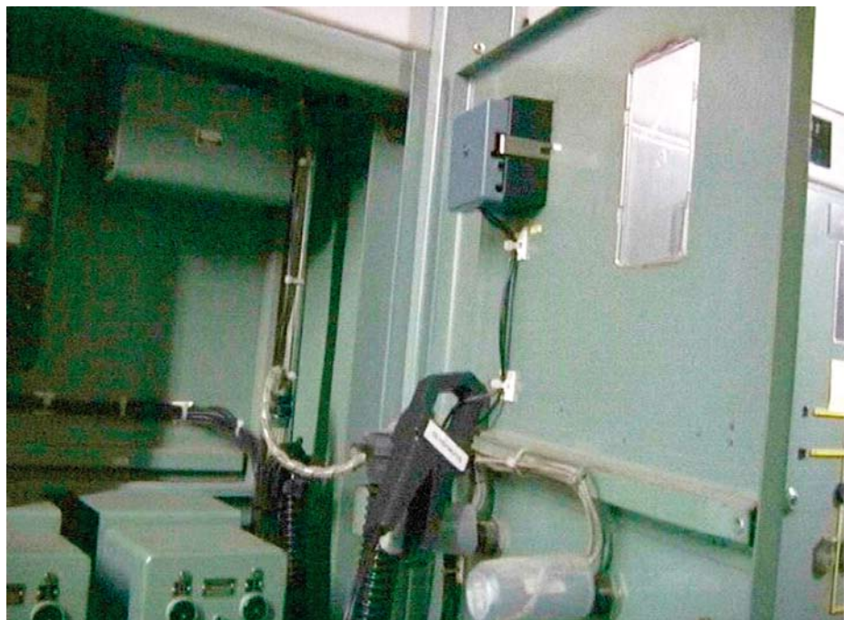
KUVA 1. Staattorivirran mittaus toisiopiiristä virtapihdin avulla (Fortum kuva-arkisto).
