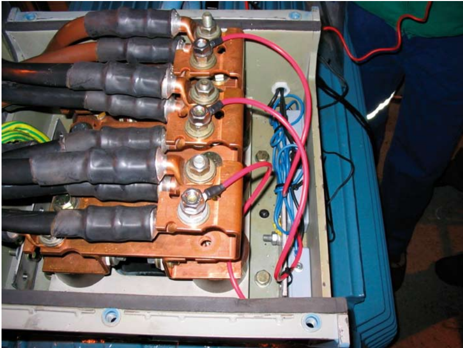
KUVA 3. Liitinjänniteantureiden asennus moottorin liitäntäkoteloon (Fortum kuva-arkisto)
